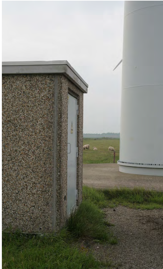
Losse elementen en zichtbare fundering
