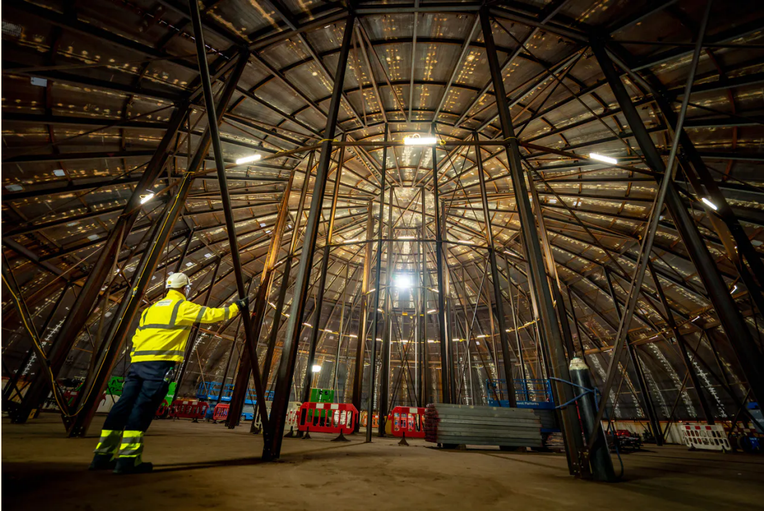
Kerncentrale Hinkley Point C in aanbouw bij het Engelse Bridgwater. Het is de grootste bouwplaats van Europa. Foto: Alamy/ANP
