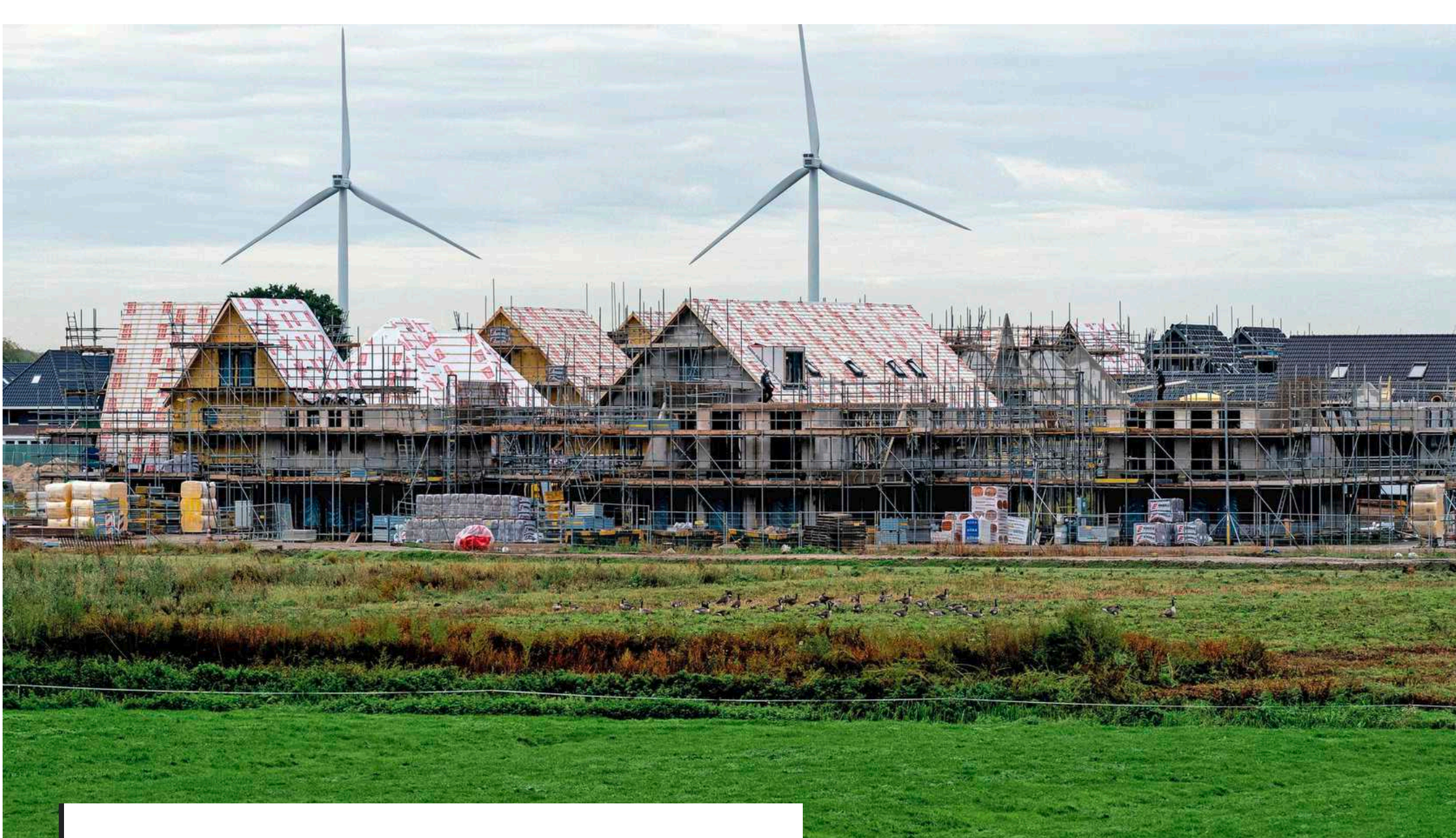
Windturbines bij Hoef en Haag, een dorp in aanbouw aan de Lek, behorend tot de gemeente Vijfheerenlanden. © ANP/HH
